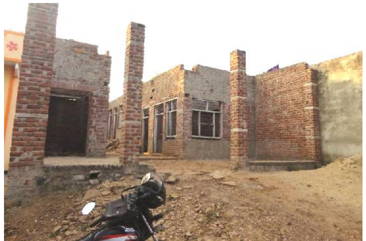
निर्माणाधीन पक्का घर
